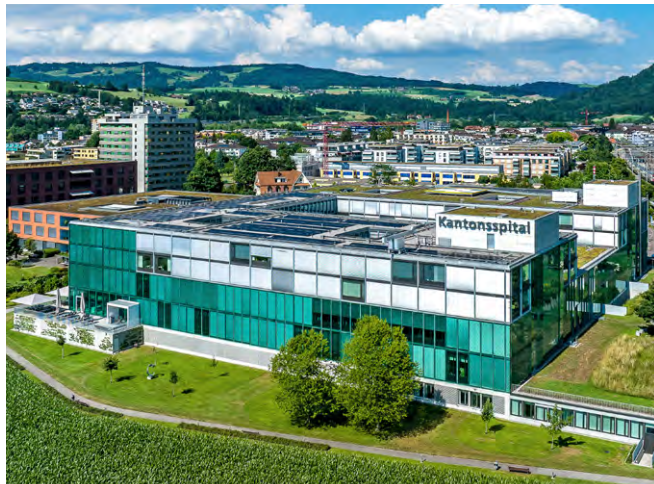
→ Die Photovoltaik-Anlage wurde im Sommer 2022 auf dem Dach des Zuger Kantonsspitals installiert.
