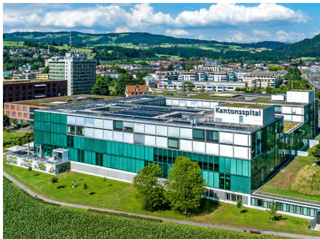
→ Die Photovoltaik-Anlage wurde im Sommer 2022 auf dem Dach des Zuger Kantonsspitals installiert.
